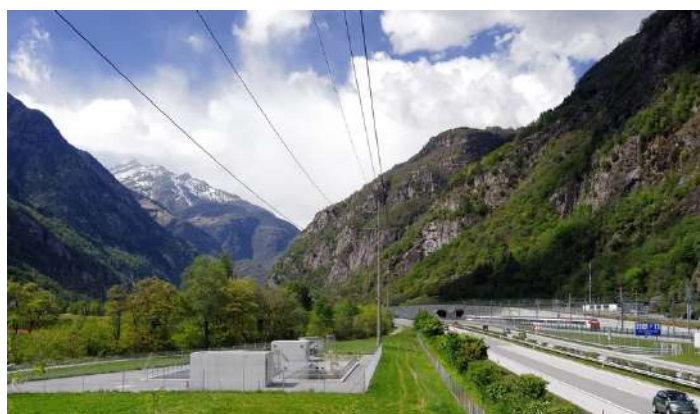
Bodio portail sud du Tunnel de base du Gothard
