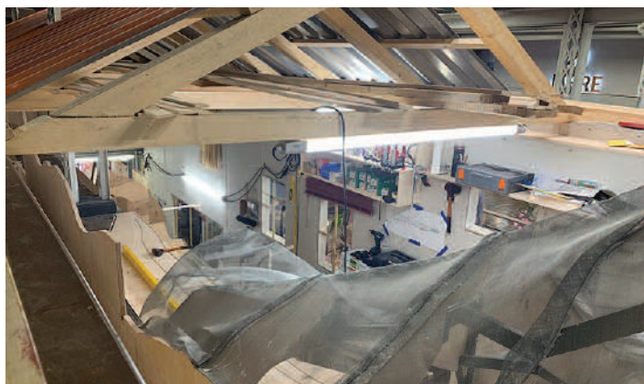
Pose du treillis pour l'ossature des montagnes andines.
