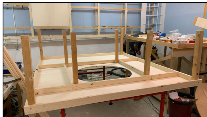
Vue intime du bâti de la rampe hélicoïdale
