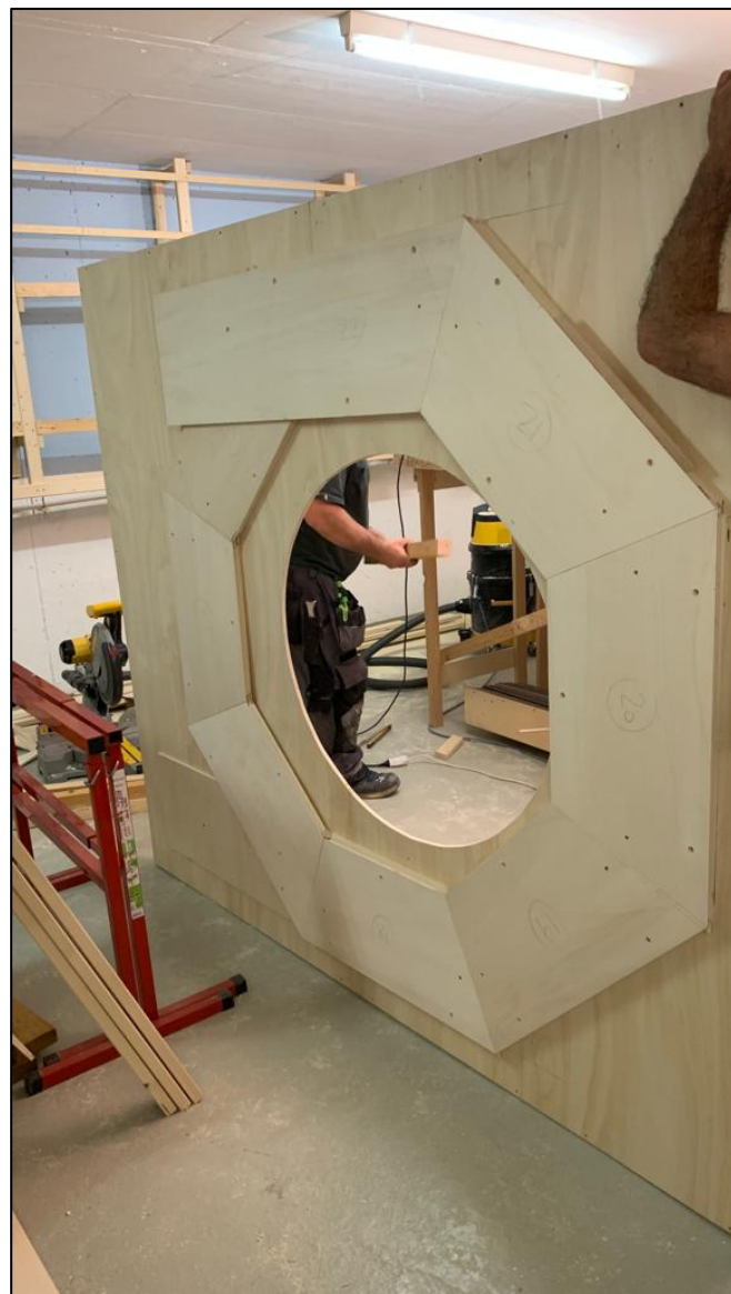
L'hélicoïdal, on remarque la construction en secteurs
