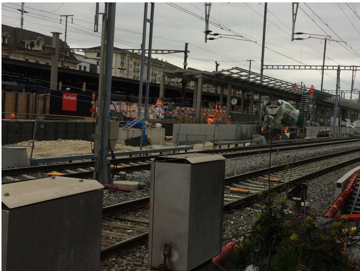
Sur cette prise de vue on voit le futur accès au quai 4.
