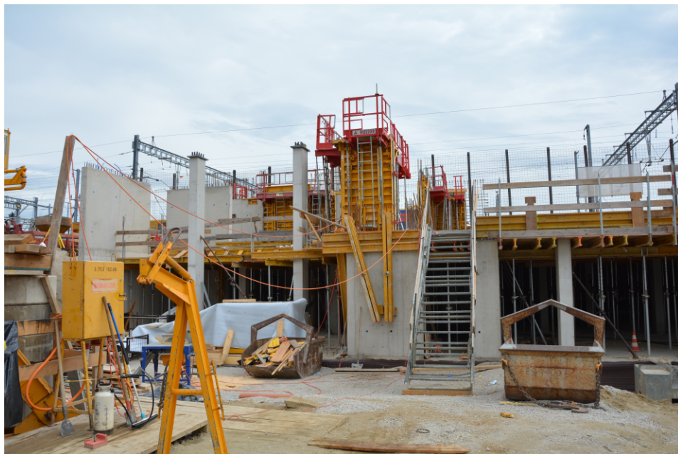
Agrandissement du passage sous-route du Léman, situé à l'est de la gare. Elargissement suite à l'augmentation du nombre de voies en direction de Lausanne.
