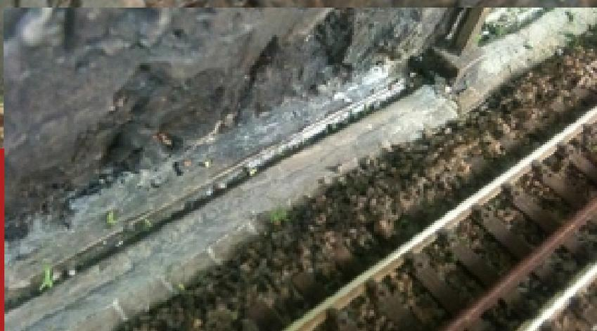
**Le détail intéressant du rocher renforcé. Il attend encore quelques détails. En bas le caniveau qui draine les ruisselements de la falaise.**
