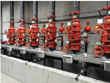
Vannes pour le système d'incendie assuré par des Sprinklers répartis dans tout le dépôt.
